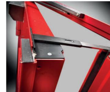
**10** Toutes les portes coupe-feu sont pourvues d'un renfort côté paumelles pour permettre l'installation de ferme-portes à bras compas ou à coulisse même dans un 2<sup>ème</sup> temps.
