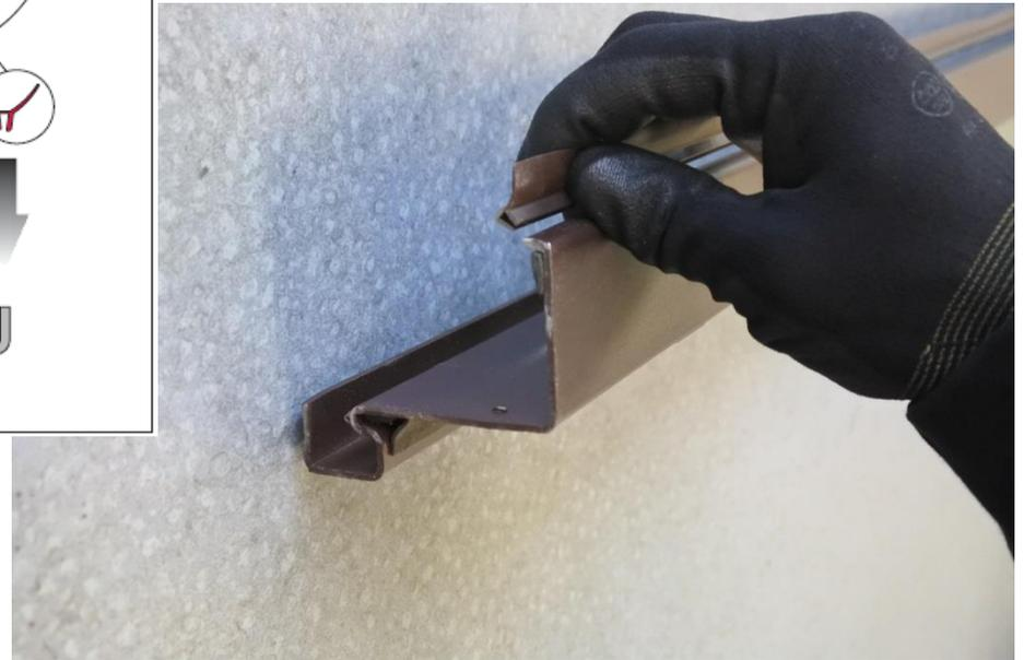
Mise en place joint de finition intérieur cadre
