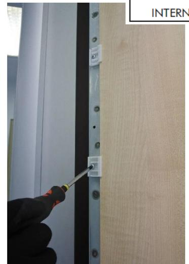
Pour une configuration carénage baguette (à clipser), il suffit juste de déclipser la baguette côté serrure, puis de dévisser les supports plastiques et d'appliquer la même méthode que précédemment.
