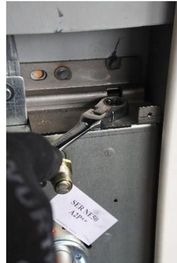
Dans le cas d'une serrure A2P\*\*, le démontage de la serrure se fait par l'intermédiaire de 4 écrous (voir photo). La serrure étant réglable en profondeur, il faudra prêter une attention particulière lors du remontage de celle-ci afin de la positionner dans le même axe d'origine.
