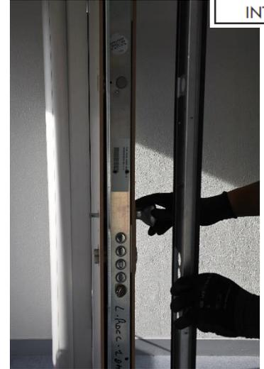
Il faut déclipser le carénage côté serrure de bas en haut.
