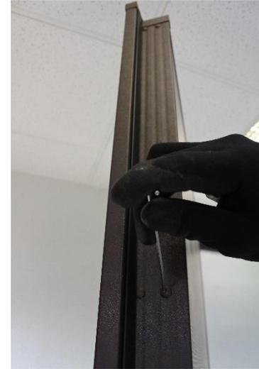
Il faut retirer les angles de finition et enlever les rivets plastiques sur toute la hauteur du carénage en poussant la tige de chaque rivet à l'intérieur du vantail.
