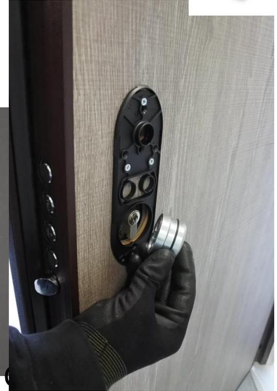
Dévisser côté intérieur les 2 vis de fixation du cylindre avec une clé allen 5 puis retirer délicatement la rondelle côté intérieure, le protecteur côté extérieur puis le cylindre.
