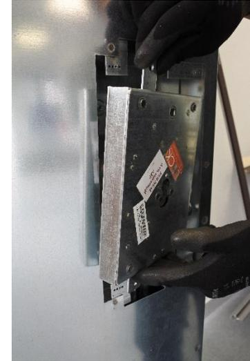
Une fois les tringleries hautes et basses désolidarisées, la serrure peut-être dévissée (4 vis en façade) et démontée.
