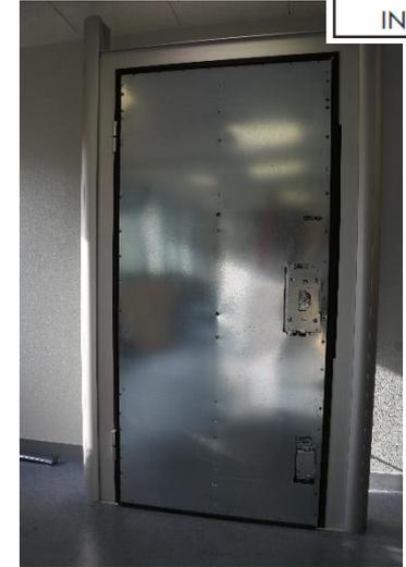
Il faut bomber le panneau en son centre pour échapper le cylindre et le carré de la béquille et faire coulisser le panneau parallèlement au vantail de 2 cm côté serrure pour qu'il se déclipse du carénage arrière. Puis bomber le panneau en son centre pour déclipser la partie haute puis la partie basse. Le remontage du panneau se fait en sens inverse.
